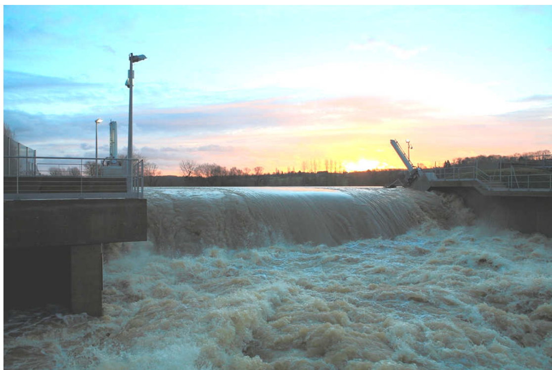
La régulation du débit de l'Oise à 160 m 3 /s par l'ouvrage de Proisy
