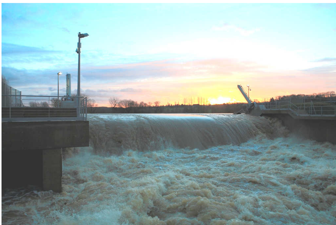
La régulation du débit de l'Oise à 160 m 3 /s par l'ouvrage de Proisy
